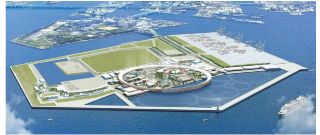
図 2 大阪・関西万博 夢洲俯瞰図 (大阪府 HP より)
